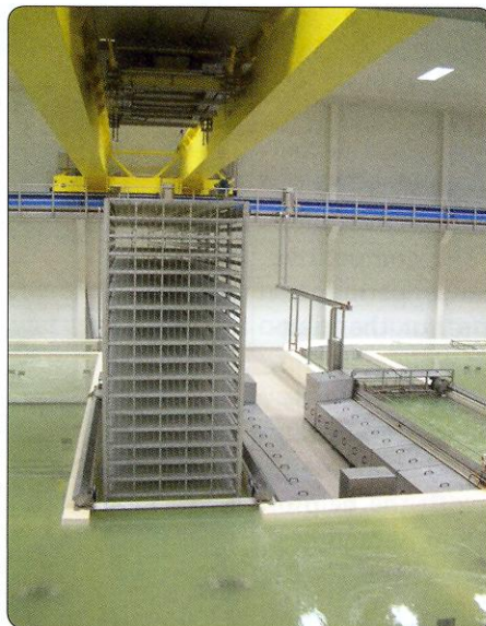
De Klokslag brining system (Phpt: GEA TDS)
